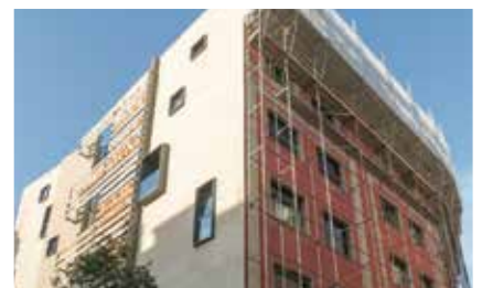
Rehabilitación de fachada en edificio residencial de la Plaza 8 de Marzo. Barcelona
